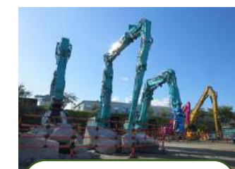
重機解体ショー
